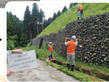
治山施設の点検
