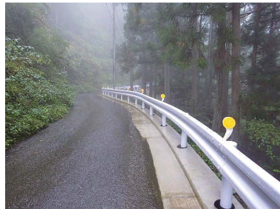
入間白岩林道 (ガードレール設置工)
