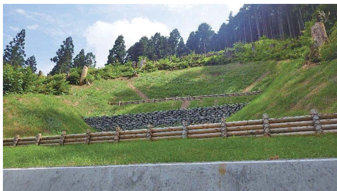
下元郷治山施設災害復旧工事 (西多摩郡檜原村下元郷)
