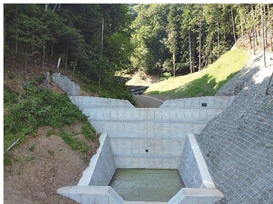
佐戸林地荒廃復旧工事 (西多摩郡檜原村数馬) 工種：谷止工
