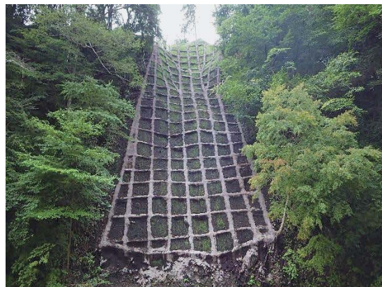
長竹治山工事 (あきる野市乙津) 工種：簡易法枠工
