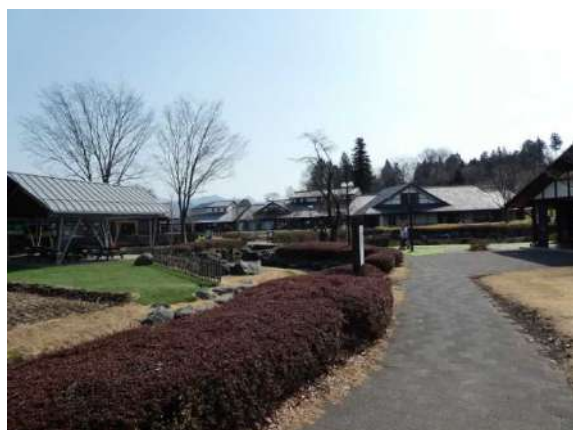
道の駅（川場田園プラザ）
