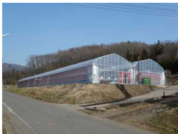
バイオマス発電所の廃熱を利用したハウス
