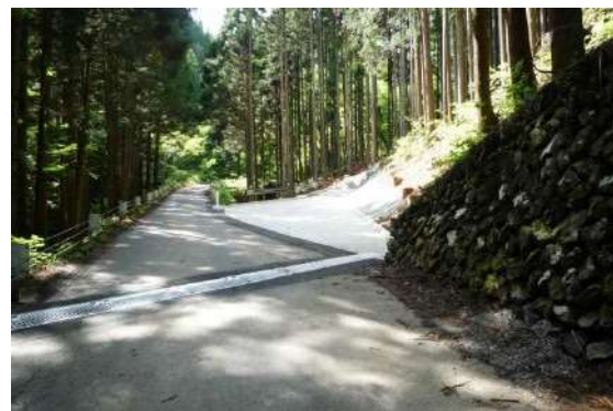
鋸山林道との接続（檜原村神戸）施工後
