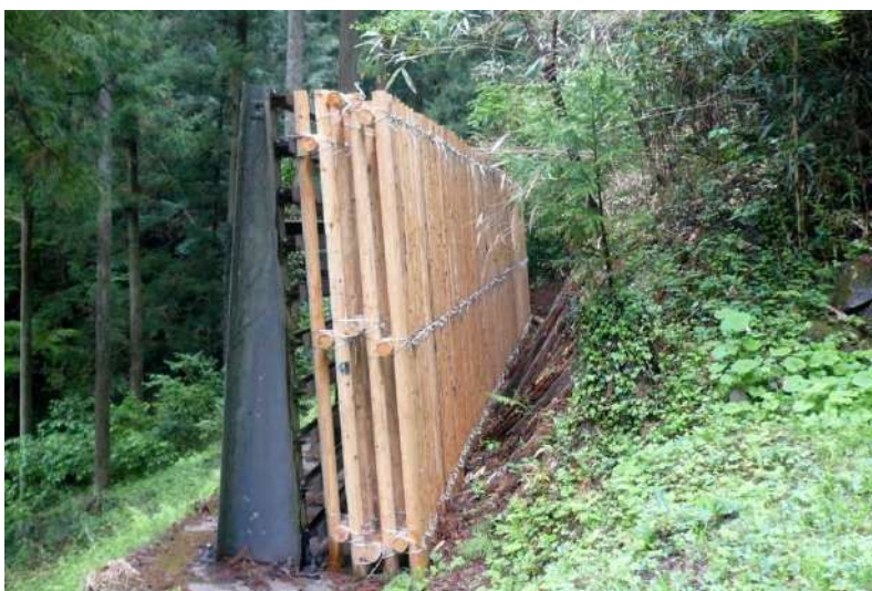
平成 29 年度大久野治山施設災害復旧工事（日の出町大久野） 落石防止緩衝工：木材使用量 17.5 m 3
