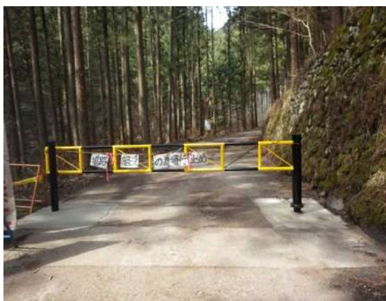
侵入防止柵設置
