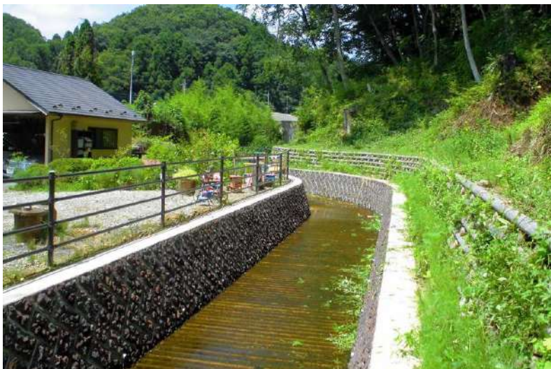
平成 29 年度上川治山工事（八王子市上川町） 木製底張工、木製土留工ほか：木材使用量 32.9 m 3
