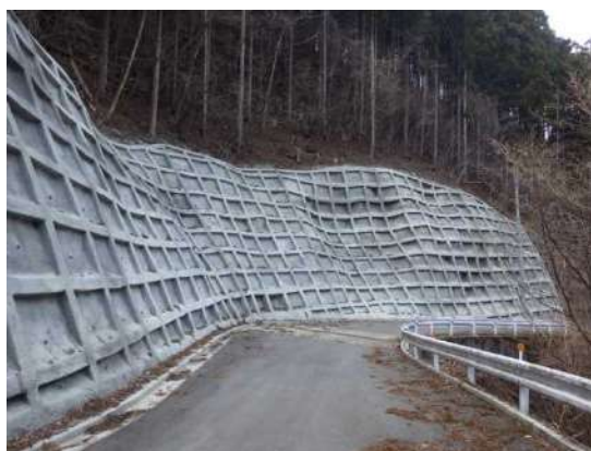
入間白岩林道（法枠工）
