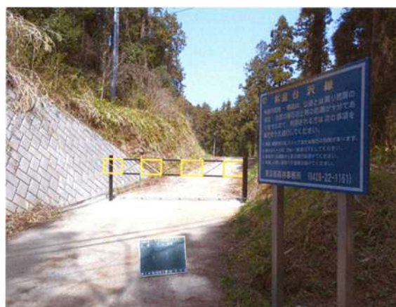
道路附属施設設置（起点看板）
