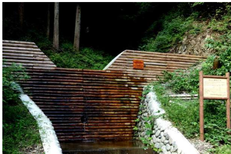
平成29年度盆堀沢治山工事（あきる野市戸倉）
