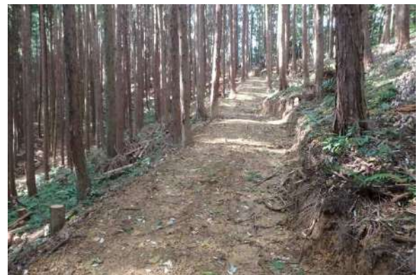
森林作業道整備状況(青梅市駒木町)
