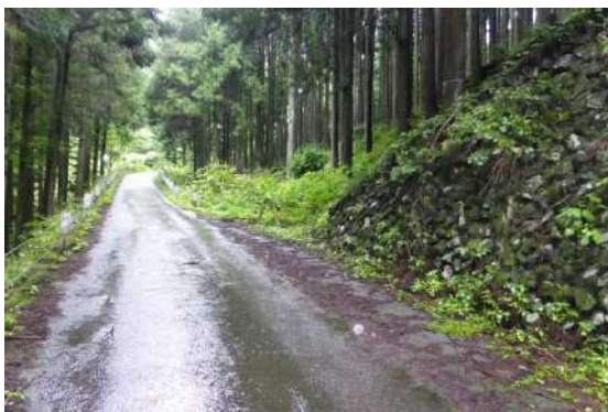
鋸山林道との接続（檜原村神戸）施工前
