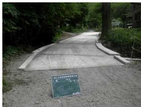
日影林道（Co路面工）
