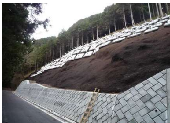
なちやぎり林道（アンカー工）
