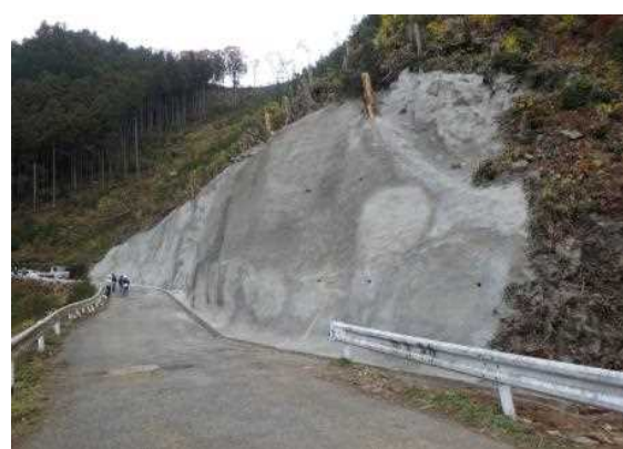
盆堀林道（モルタル吹付工）
