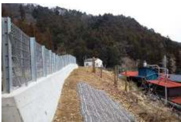
工事完了直後（29年3月）
