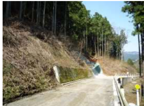
坂東沢丹田林道との接続（檜原村人里）施工後
