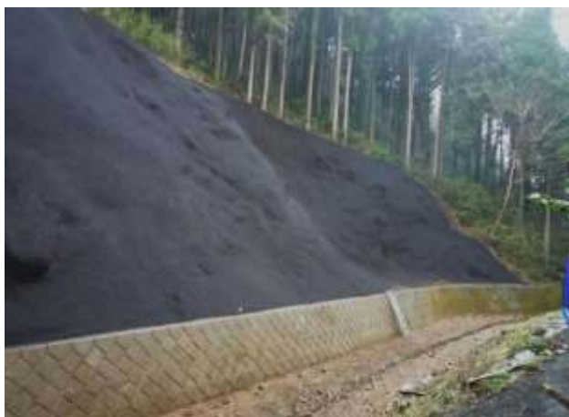
工事完了直後（29年3月）
