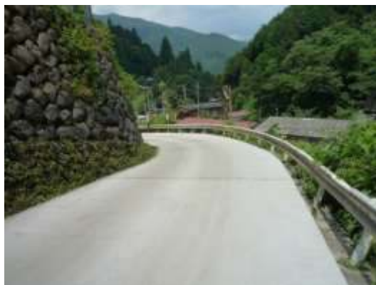
鋸山（大沢入）林道（Co路面工）
