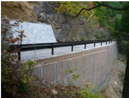
日向沢林道（L型擁壁工）
