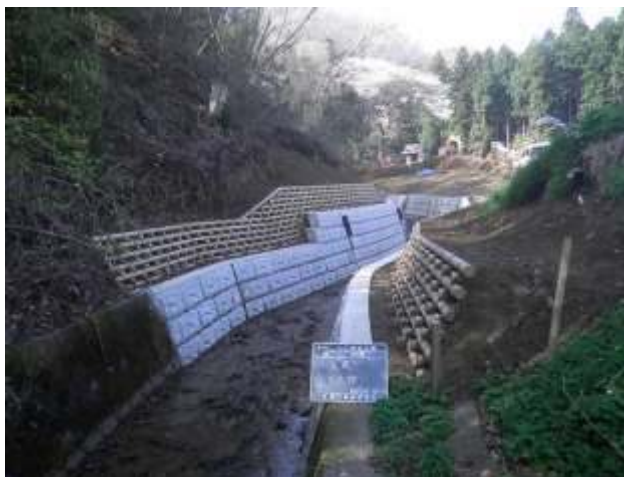
工事完了直後（29年3月）
