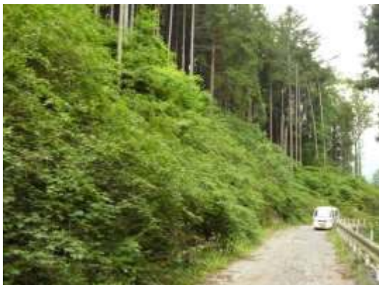
坂東沢丹田林道との接続（檜原村人里）施工前
