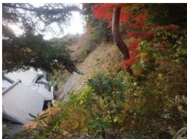
工事完了直後（28年12月）
