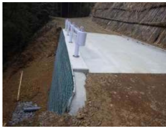
梅の木林道（簡易補強土壁工）
