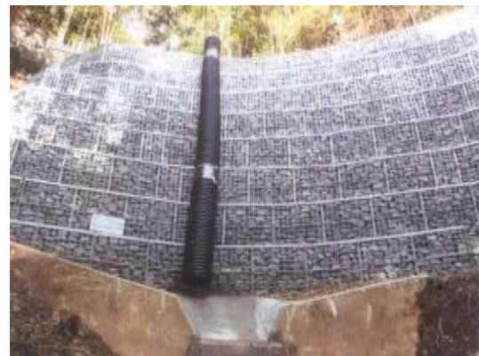
醍醐林道（大型かご枠工）
