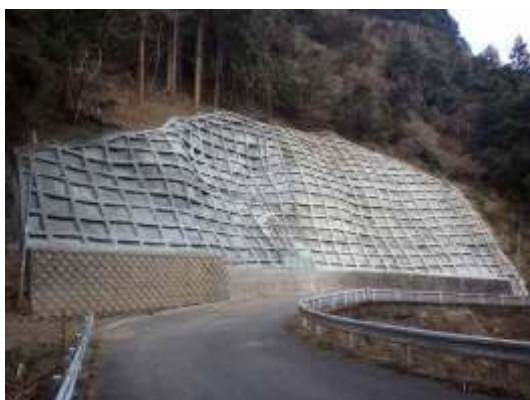
大入林道（法枠工）
