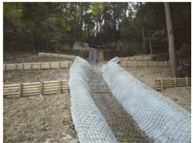
草花林地荒廃復旧工事 (その2) (水路工)
