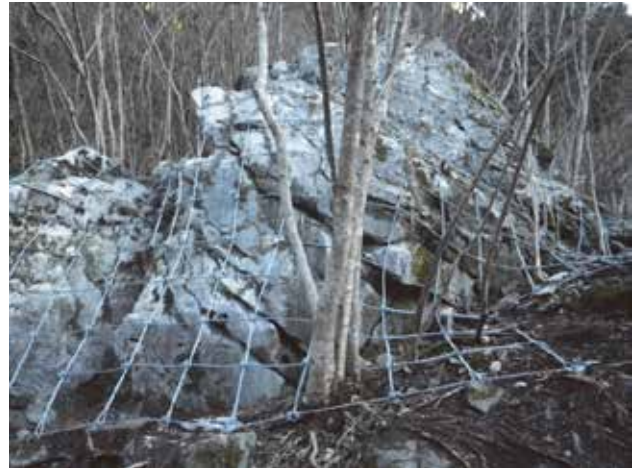
栃寄治山工事 (固定工 ロープ伏工)
