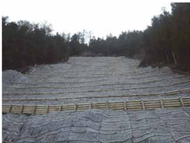
赤井沢水源の里保全緊急整備 (筋工)
