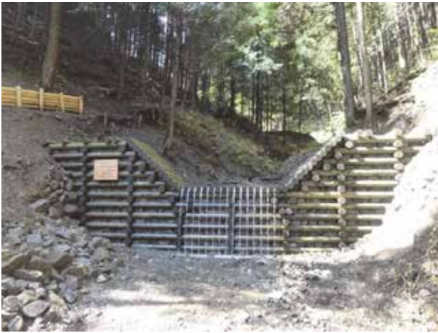
栗平施設災害復旧工事 (床固工)
