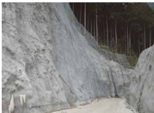
御前山林道（落石防護網工）
