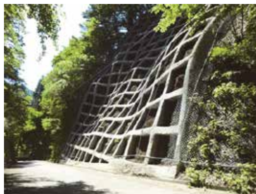
大入林道（吹付法砕工）
