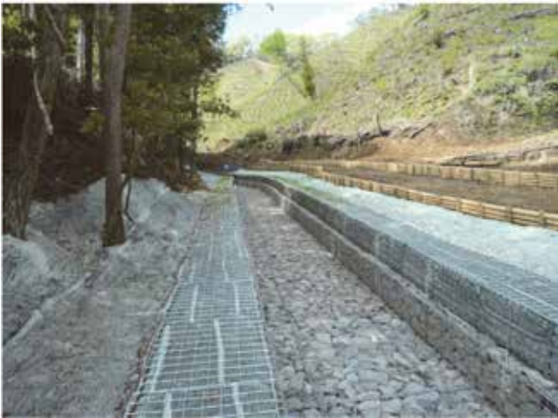
初沢治山工事 (護岸工)
