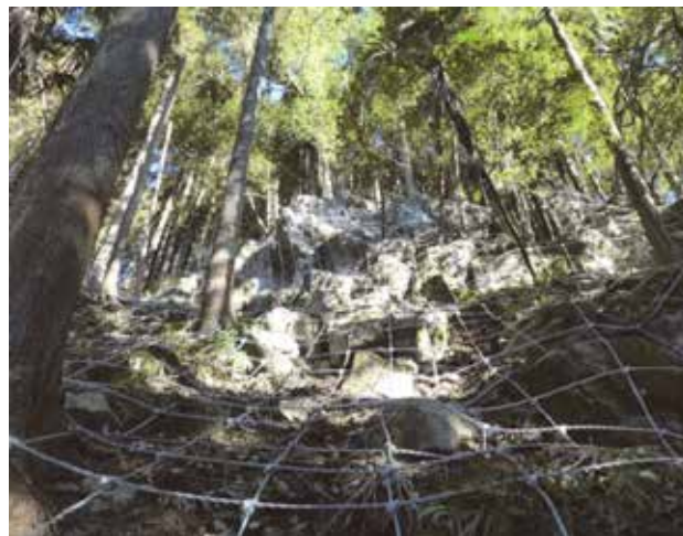
白丸予防治山工事 (ロープ伏工)
