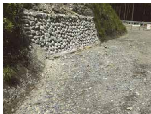
板東沢丹田林道（土留練石積工）
