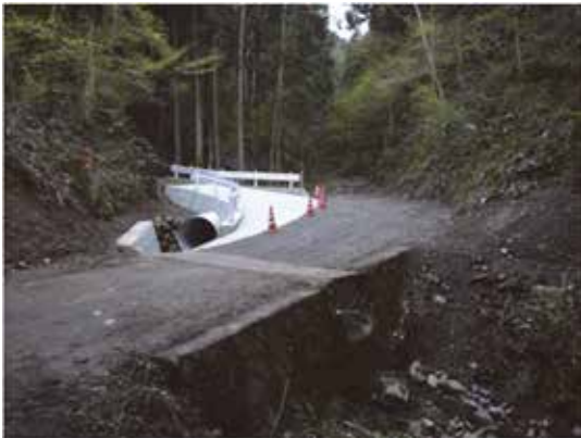
中の沢林道との接続 (八王子市上恩方町)
