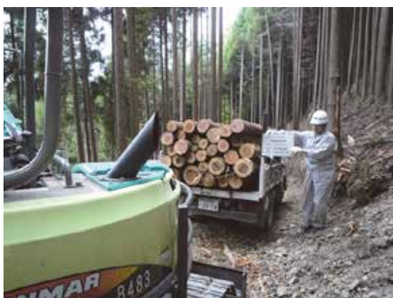
間伐材搬出（トラックにより搬出される木材）
