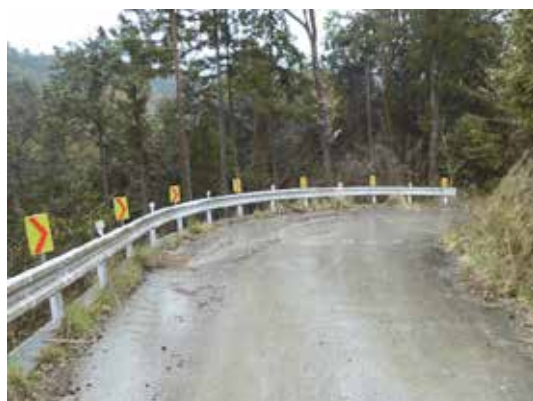
台沢林道（安全施設工）
