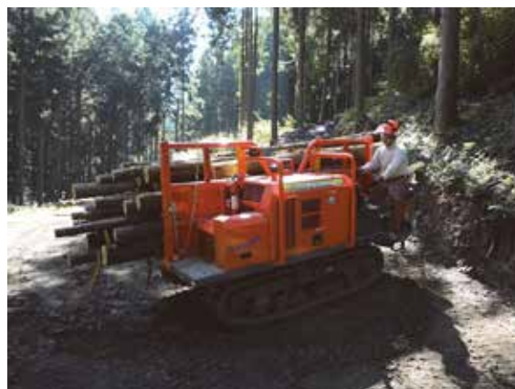
間伐材搬出（作業道を使って搬出される木材）
