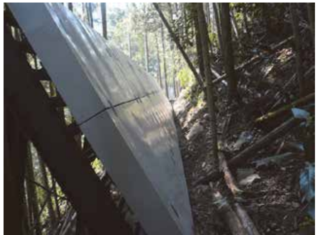
養沢川向治山施設災害復旧工事 (落石防護柵緩衝材設置工)
