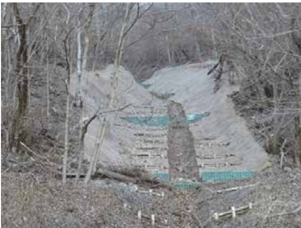
真名井沢治山工事 (丸太筋工・伏工)
