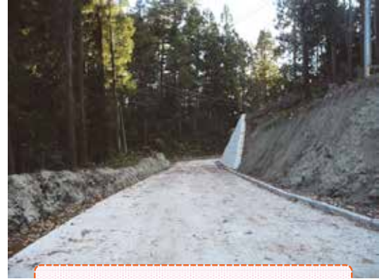
終点付近（水道施設道と接続）
