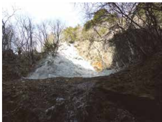
海沢林道 (モルタル吹付工)
