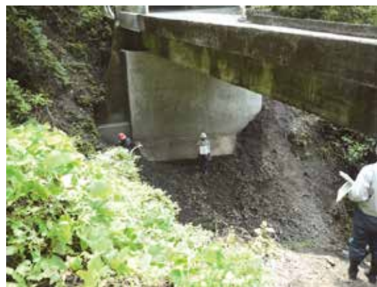
神戸林道 (橋梁補修工)
