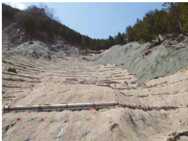
樽沢復旧治山工事 (丸太筋工・伏工)
