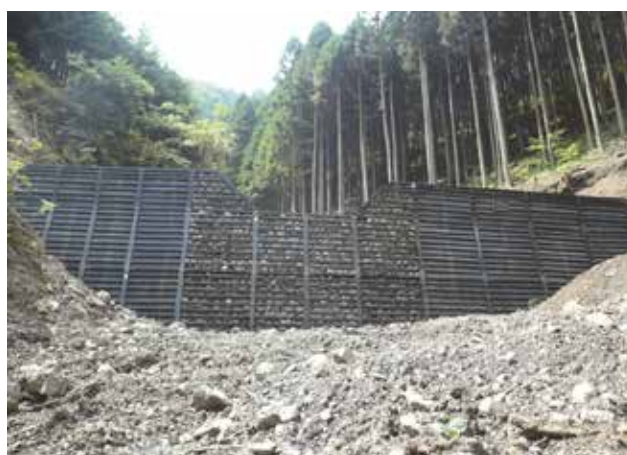
赤井沢水源の里保全緊急整備 (鋼製谷止工)
