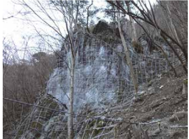
栃寄治山工事 (固定工 ロープ伏工)
