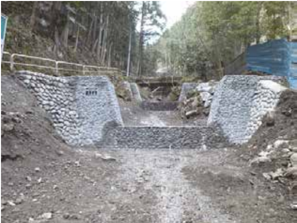
日原大沢治山工事 (床 固 工)
