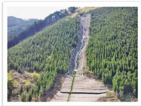
御岳林地荒廃復旧工事 青梅市御岳一丁目地内 土留工 3基・法枠工 A=3525 m 2 ・筋工・伏工 木材使用量：0.7 m 3
