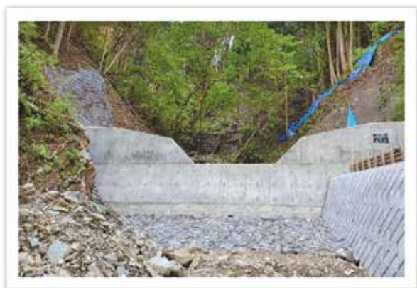
数馬治山施設災害復旧工事 西多摩郡檜原村数馬地内 谷止工 1基 L=15.0m H=4.5m V=123m 3
