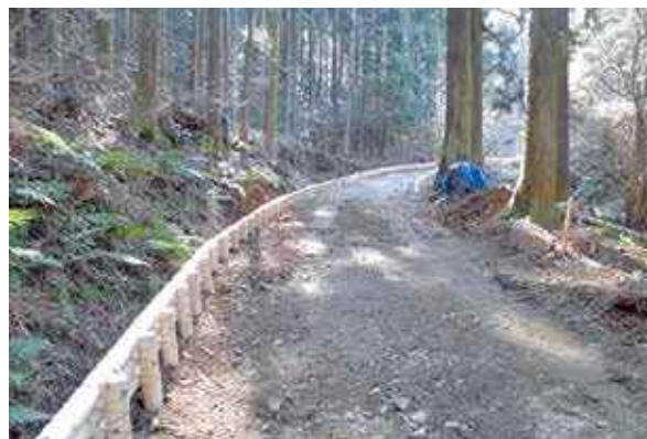
完成（日影林道）
