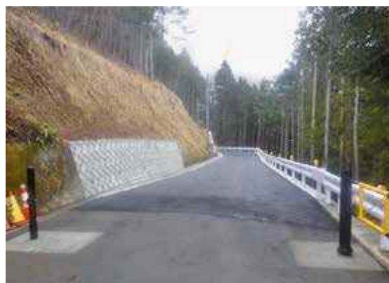
完了（不老林道）
