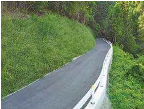
星竹林道（法面工・舗装工）
