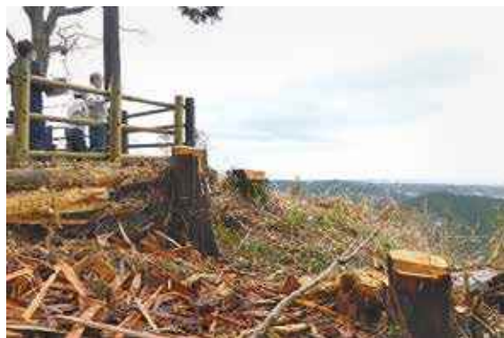
景観伐採・園地（木柵）整備（日の出町勝峰山）
