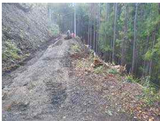
施工前（不老林道）
