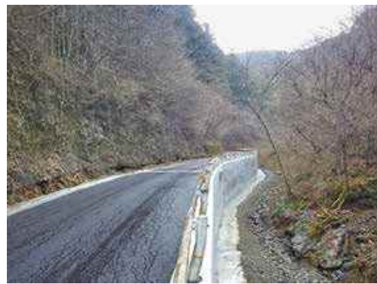
盆堀林道（擁壁工・舗装工）
