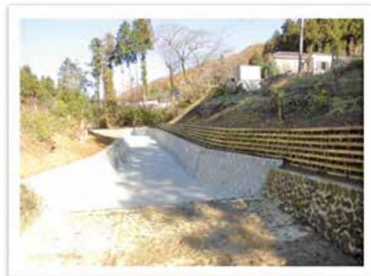
滝の沢治山工事 八王子市下恩方町地内 護岸工 L=171m H=1.5m・丸太積工 A=52 m 2 木材使用量：5.6 m 3
