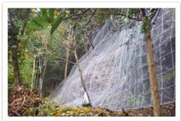
肝要復旧治山工事 西多摩郡日の出町大久野地内 固定（ロープ伏） A=480 m 2
