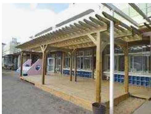
【木製外構施設の整備】
