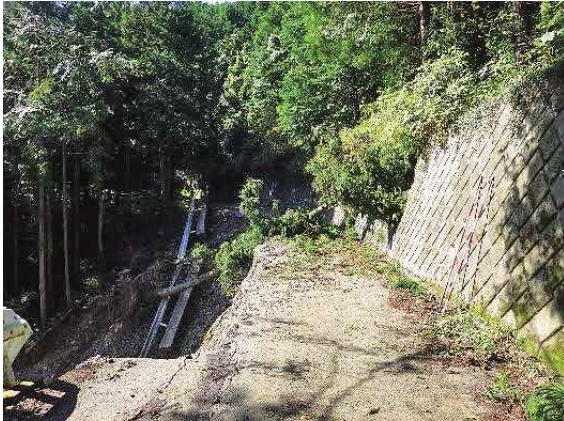
災害復旧工事の写真
