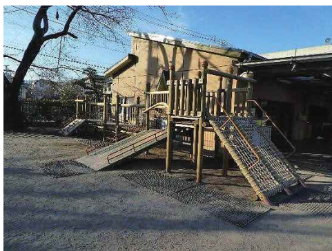
【木製遊具の整備】
