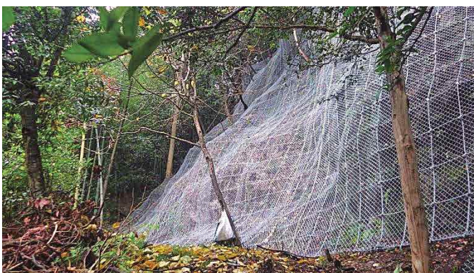
肝要復旧治山工事 （固定（ロープ伏） A=620.0 m 2 ）
