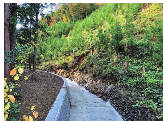
下恩方（松竹）治山施設災害復旧工事 （護岸工 L=113.0m H=1.5m）
