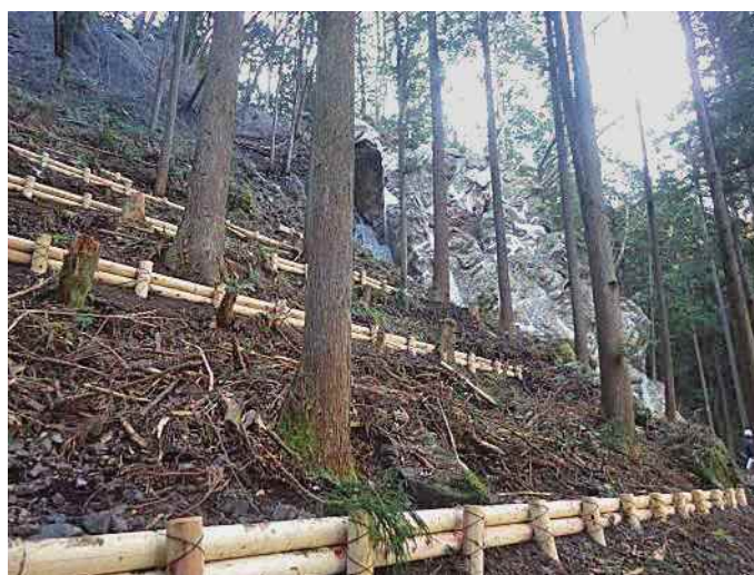
養沢（木和平）復旧治山工事 筋工（丸太筋）：木材使用量 5.3 m 3
