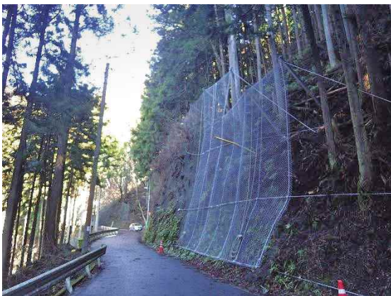
改良工事の完成写真
