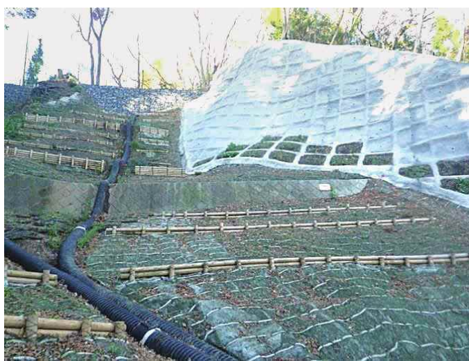
草花（江里上谷津）治山工事 筋工（丸太筋）、木柵工：木材使用量 7.1 m 3
