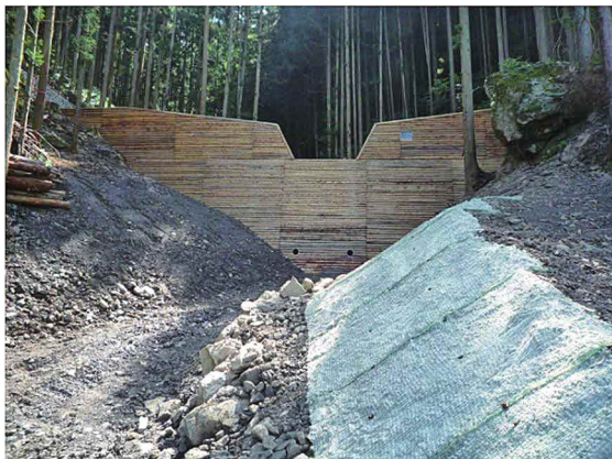
井戸入（盆堀沢）予防治山工事 （谷止工 L=29.5m H=7.0m） 木材使用量：66.6 m 3
