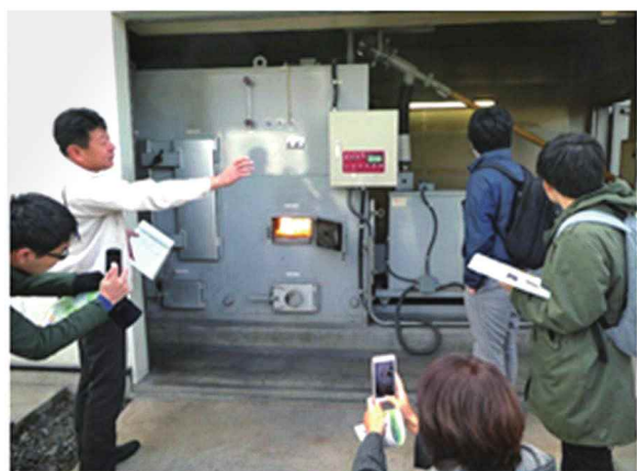
山梨市地域交流センターの木質ペレット冷暖房システムを見学
