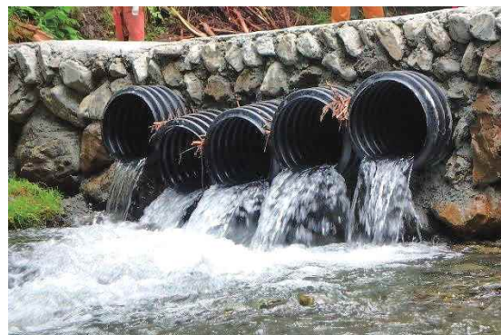
暗渠及び洗い越し施設 (檜原村本宿)
